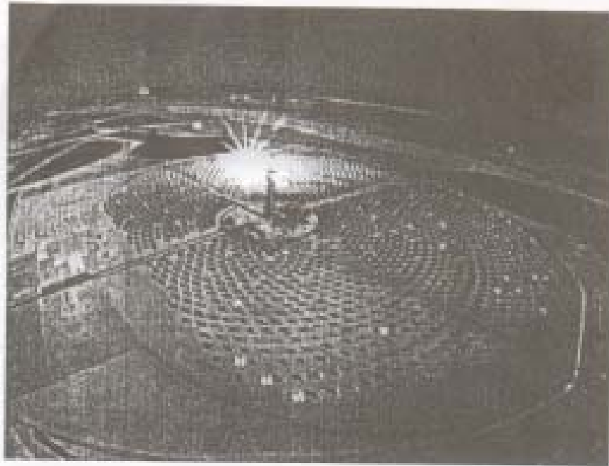
Μία άποψη ενός σταθμού ηλιοστάτη. Παράγει ενέργεια 10 MWe
