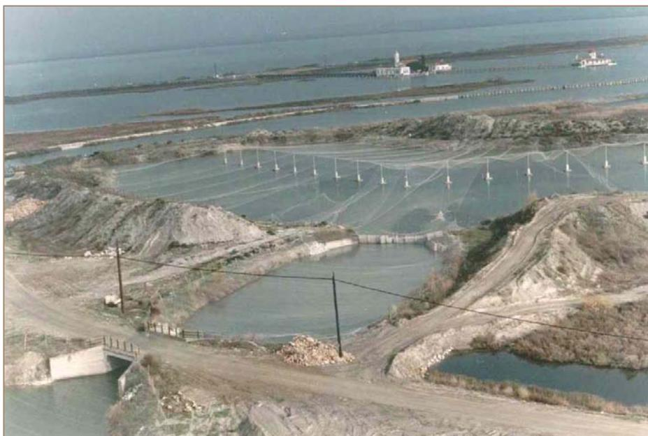
Σχήμα 56: Δύο μονάδες για αντιπαγετική προστασία και θέρμανση τεχνητών λιμνών για ιχθυοκαλλιέργεια στο Πόρτο-Λάγος και στο Ν. Εράσμιο Ξάνθης
