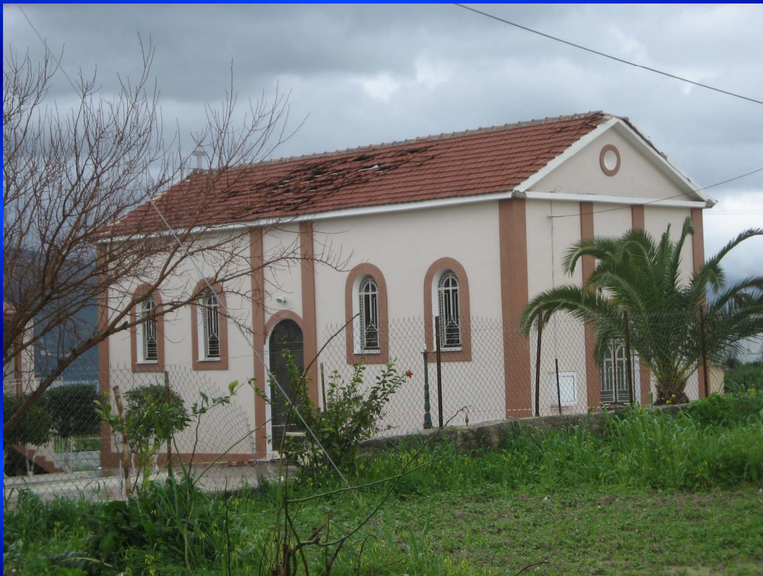
Ναός, στον Άγιο Δημήτριο. Συχνά εμφανιζόμενη βλάβη μετακίνησης κεραμιδιών.
