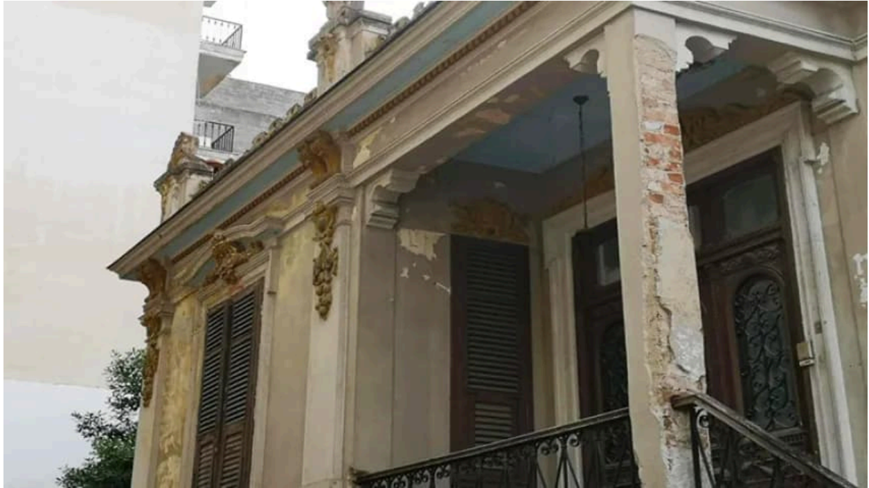
Διατηρητέο κτίριο στη Θεσσαλονίκη / Μακεδονικά Νέα
