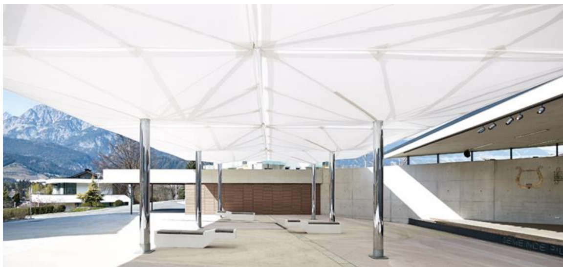
ΥΛΟΠΟΙΗΜΕΝΗ ΚΑΤΑΣΚΕΥΗ ( ΤΥΠΟΥ ΟΜΠΡΕΛΑ) , ΠΙΛΛΣ, ΑΥΣΤΡΙΑ
